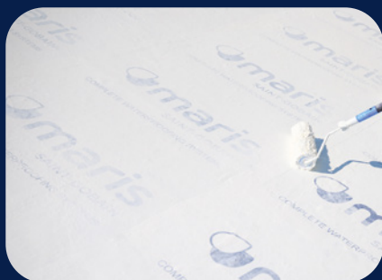
PASUL 7 Al 2-lea strat de membrană hidroizolantă
