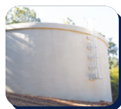
Rezervoare de apă
