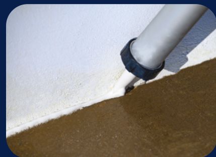
PASUL 3 Repararea fisurilor și îmbinărilor
