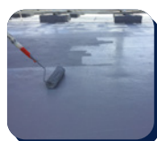
Acoperișuri, terase și balcoane
